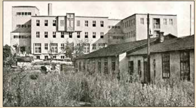
Im Vordergrund die bereits verfallene Baracke von Anna Ehm, im Hintergrund die neu erbaute Neulandschule
